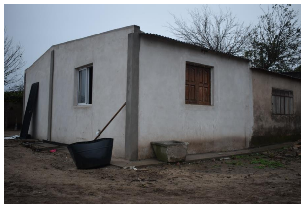
Figura 6. Vista exterior de la nueva sala de faena.
